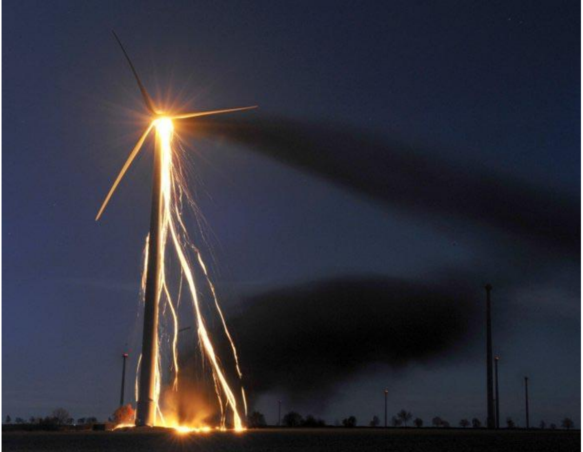
Im Dezember 2009 brennt eine Windkraftanlage im Kreis Uelzen, auslaufendes Öl trägt das lodernde Feuer auf den Boden.
